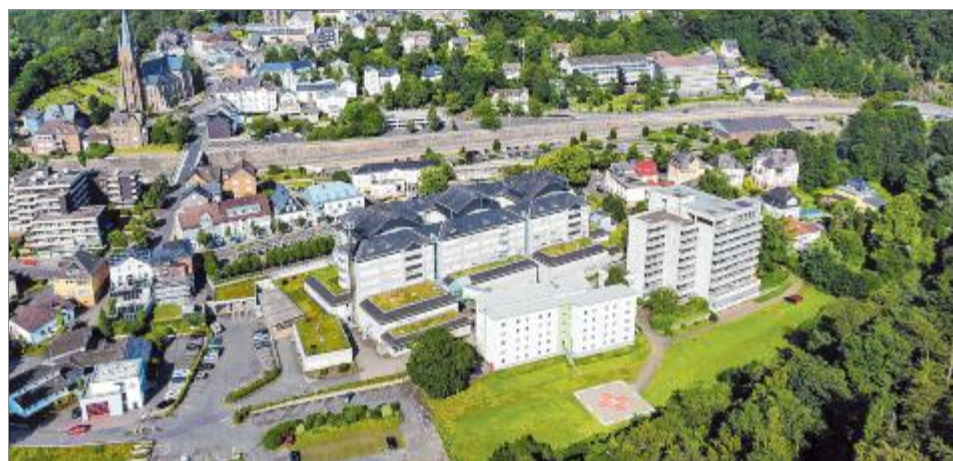
Das DRK hat nach Auffassung des Kreises nicht genug ins Krankenhaus Kirchen investiert: Die Sanierung wird nach aktueller Schätzung 40 Millionen Euro kosten. Foto: Daniel Montanus
